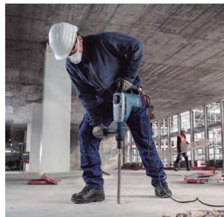
Los bordes de corte planos a 180 grados y la punta centradora piramidal garantizan a los profesionales un centrado estable y preciso. La exclusiva tecnología de soldadura por difusión de Bosch (IDS) garantiza una unión fuerte y duradera entre la cabeza y la espiral. Así, se consigue una mayor resistencia a la tensión y al calentamiento.
